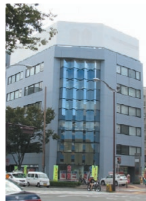
大橋花村ビル外観
