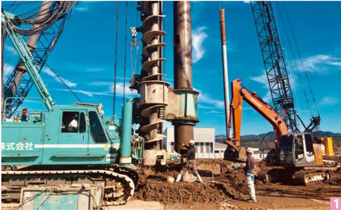
1 基礎工事の現場はダイナミックだ。オーガスクリューで掘削する穴は、数メートルから50メートルを超えるという
