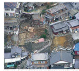
福岡県西方沖地震で被災した五野島の津屋(平成17年3月)
