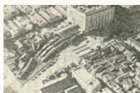
高架化される前の西鉄福岡駅周辺
