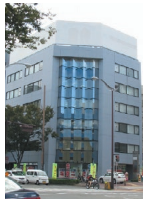
大橋花村ビル外観
