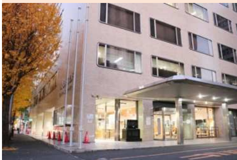
▲正面車寄せ。立体駐車場を併設。
