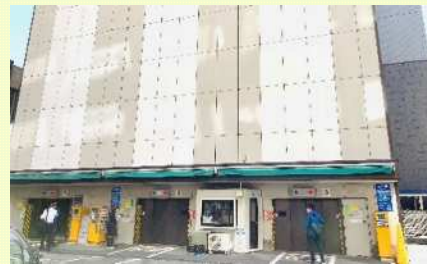
▲福岡商工会議所 立体駐車場
