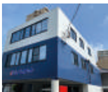
株式会社プロテック 福岡市博多区南5丁目18-20 TEL 092-473-8621 HP: https://renoprotec.com
