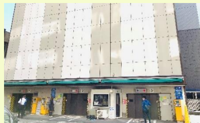
▲福岡商工会議所 立体駐車場
