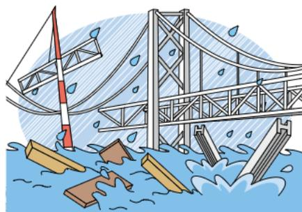
橋梁工事を行っている最中、河川で洪水が発生し、堤外地内に保管していた工事用材料が流された。
